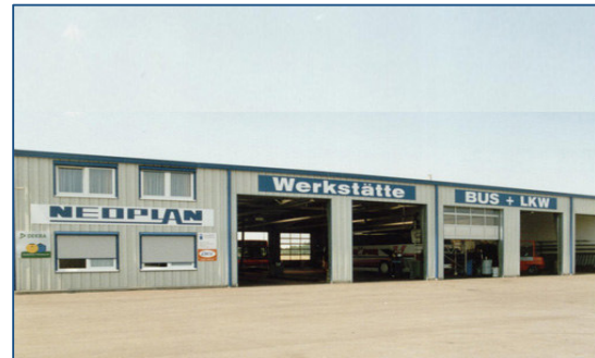
Neoplan (D), built in 1999 by Kaufmann Wohnungs- & Industriebau GmbH Surface: 1,232 m 2 Type: AZM1 Wall system: PA Roof system: PR Slope: 10 % Span: 30m
